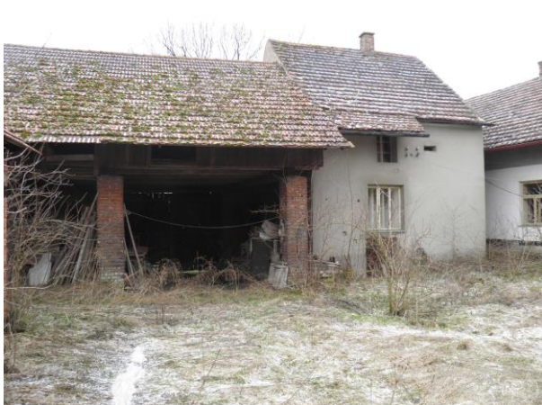
3. Pohled na dvorní stranu kolny a vejminku při jižní hranici dvoru.
