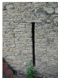
25. šterbinový větrací průduch stodoly.
