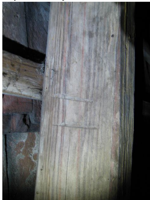
12. Tesařské značky, římská číslice a červené čáry, určené k opracování dřeva.
