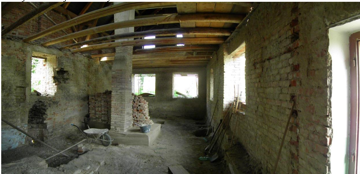
7. Pohled do prostoru světnice od vstupu, v průběhu rekonstrukce domu rok 2011. V zadní podélné zdi, vlevo, pod novodobým oknem je dochována nika po varně povidel. Vpravo od tohoto okna je vylámána kapsa po odstraněném vynášecím pasu otevřeného ústí dymníku. Stávající komín je novodobý z roku 1954.
