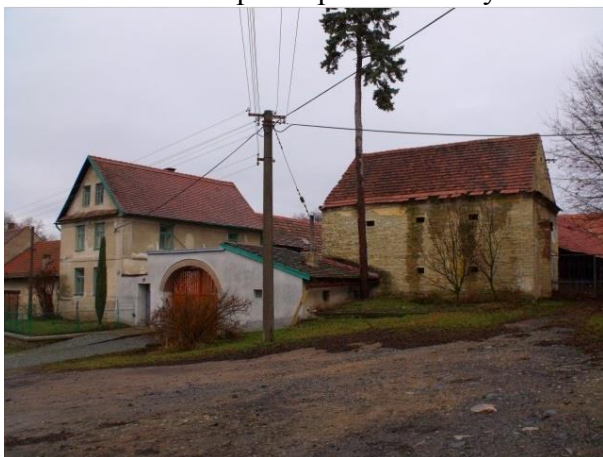
1. Pohled na dům před úpravou fasády.
