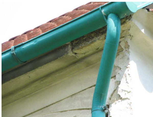
6. Detail lisenového rámu na zadní straně domu.
