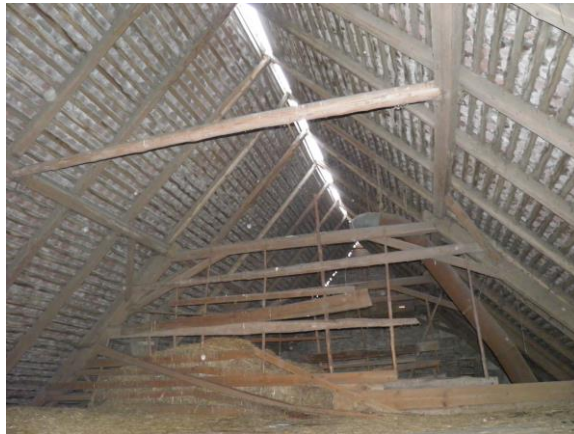
2. Rankova konstrukce krovu ve stodole.
