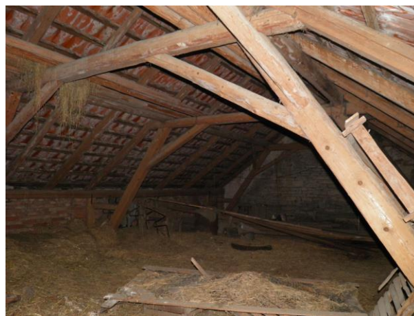
4. Pohled na vaznicový krov nad kolnou.
