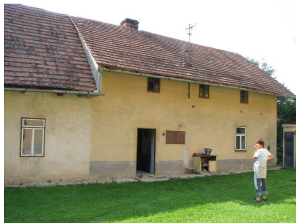
5. Pohled na zadní podélnou stranu domu. Ve zdi jsou ponechané trámy zazděné konce původní stropní konstrukce chlévů. Střecha posledního dílu chlévů domu byla odstraněna.
