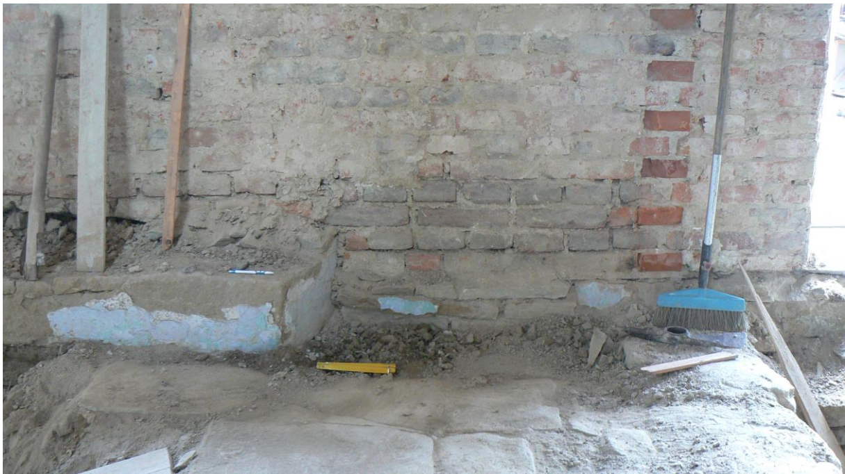
9. Pohled na fragment špalety původního vstupu s vrstvou vápenných nátěrů.
