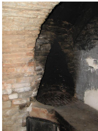
15. Pohled na plackovou klenbu síně. zaklenuté valenou cihelnou klenbou
