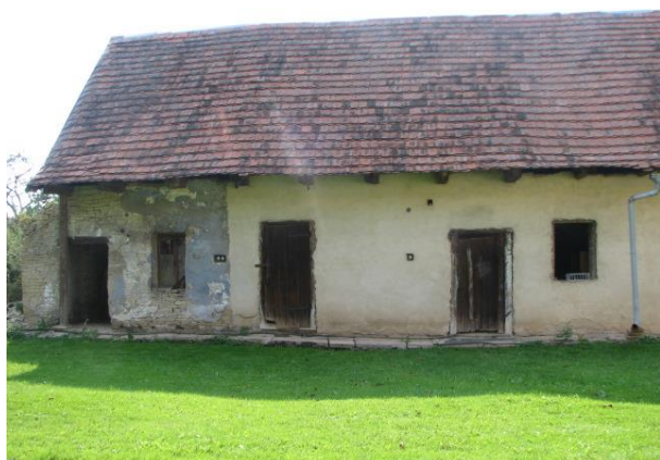
5. Pohled na zadní podélnou stranu domu. Ve zdi jsou ponechané trámy zazděné konce původní stropní konstrukce chlévů. Střecha posledního dílu chlévů domu byla odstraněna.
