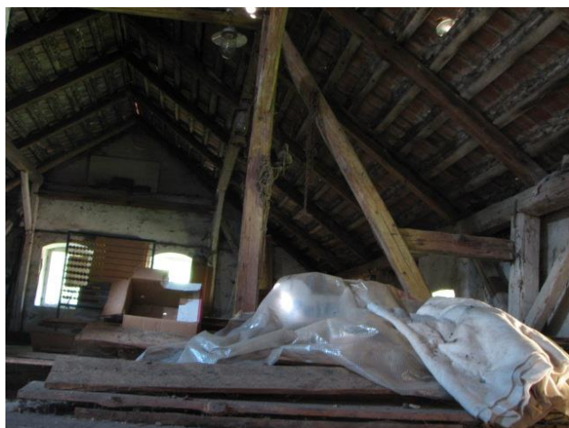
20. Pohled na krov nad první a druhým dílem domu, vaznicová soustava s dvojicí stojatých stolic.
