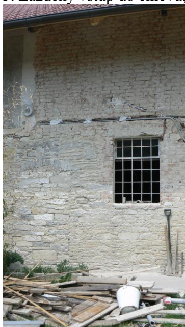
5. Zazděný vstup do chlévů, vpravo novodobé okno.
