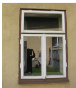
6. Okenní výplň světnice – trojdílné okno typu T, s bambulkovými závěsy z počátku 20.století
