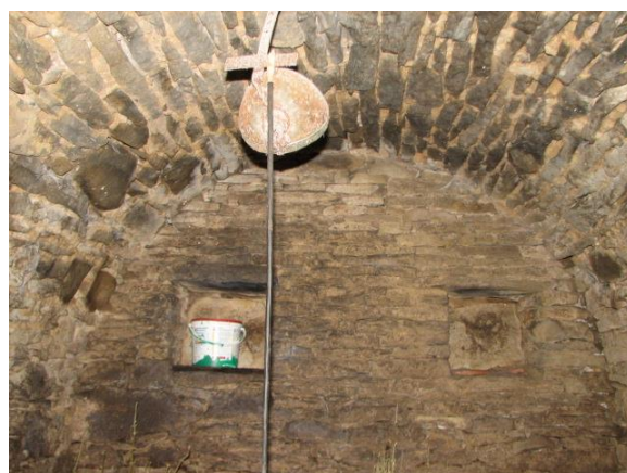
4. Pohled do prostoru sklepa.
