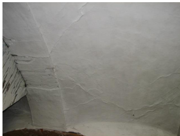
15. Pohled na plackovou klenbu síně. zaklenuté valenou cihelnou klenbou
