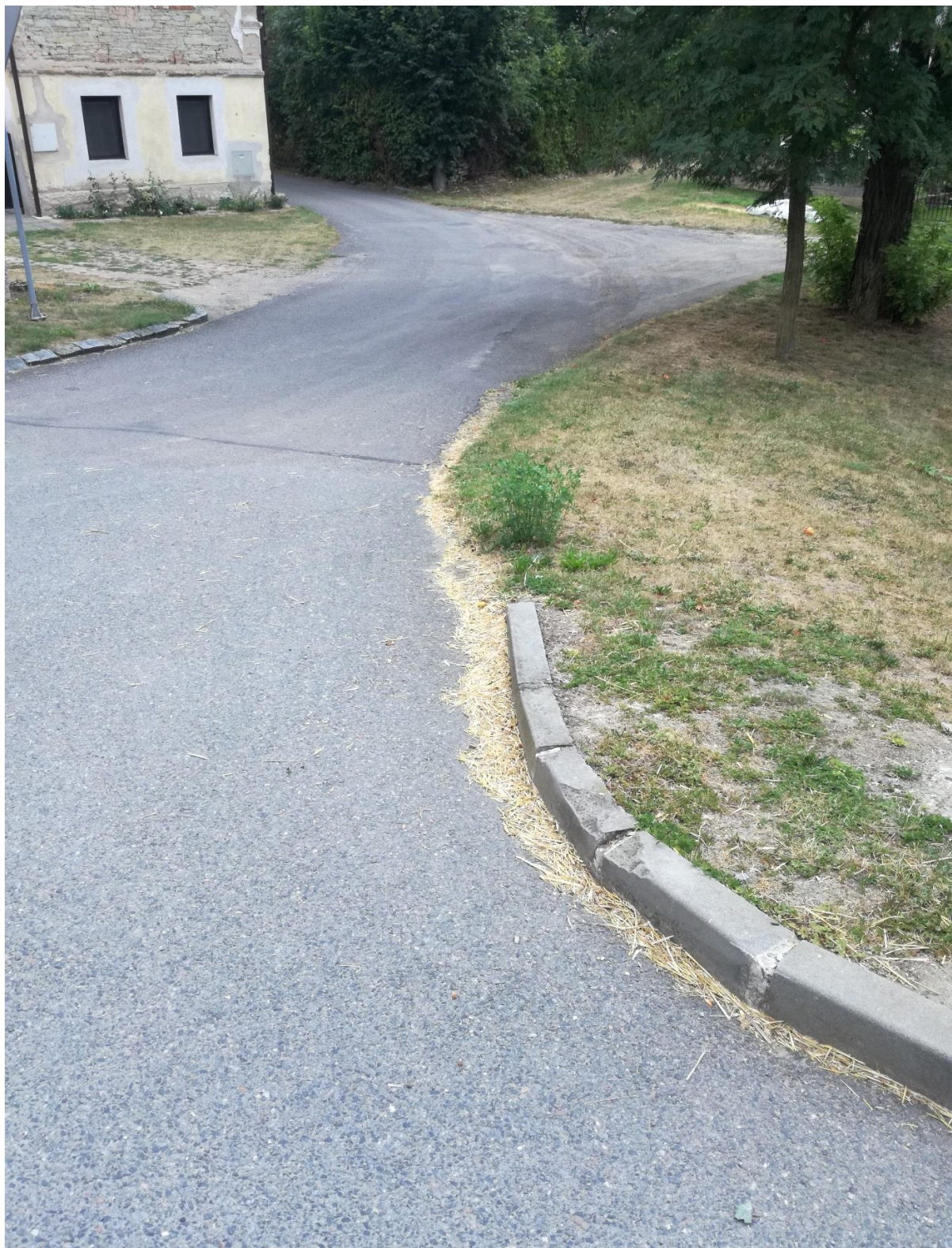
Foto 3: Předmět pasportu místních a účelových komunikací
