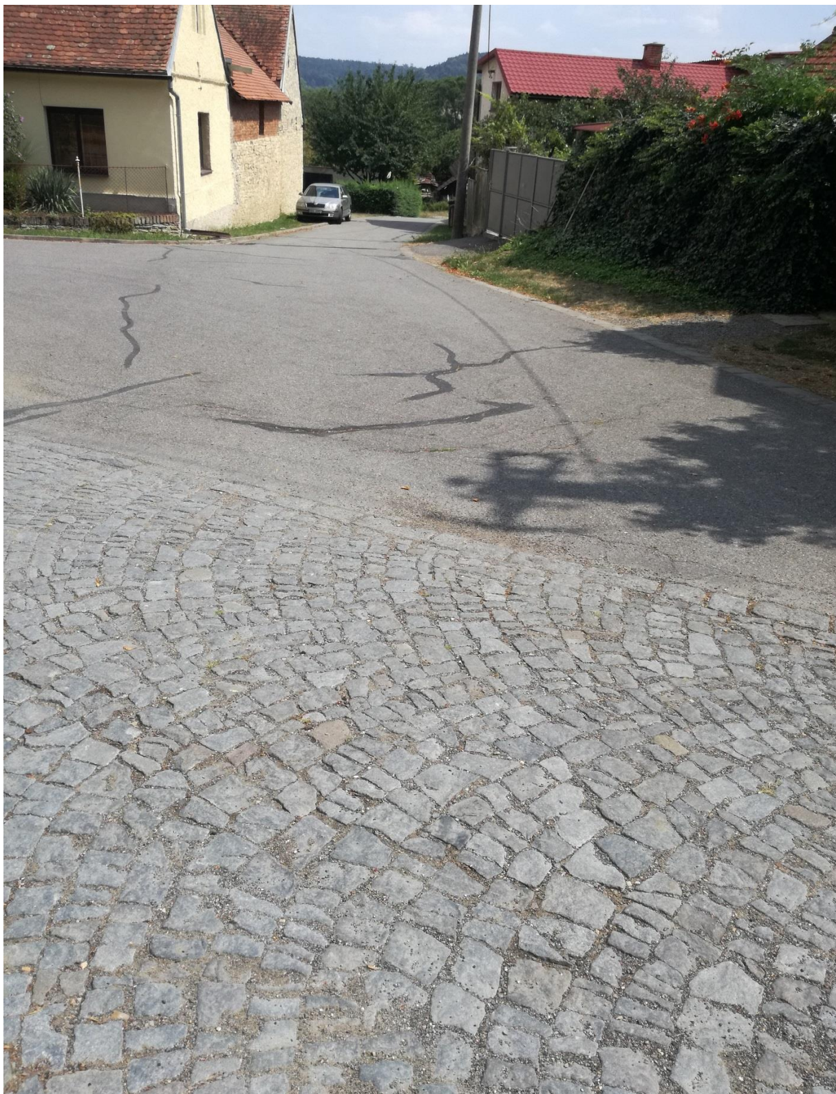
Foto 1: Předmět pasportu místních a účelových komunikací
