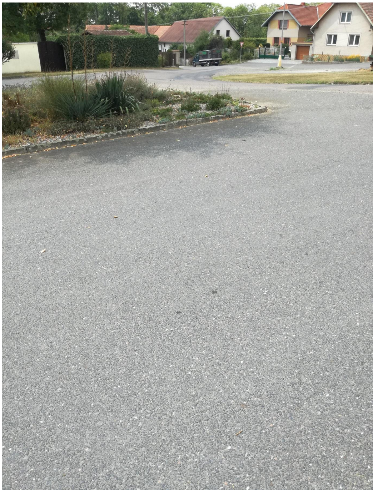
Foto 4: Předmět pasportu místních a účelových komunikací
