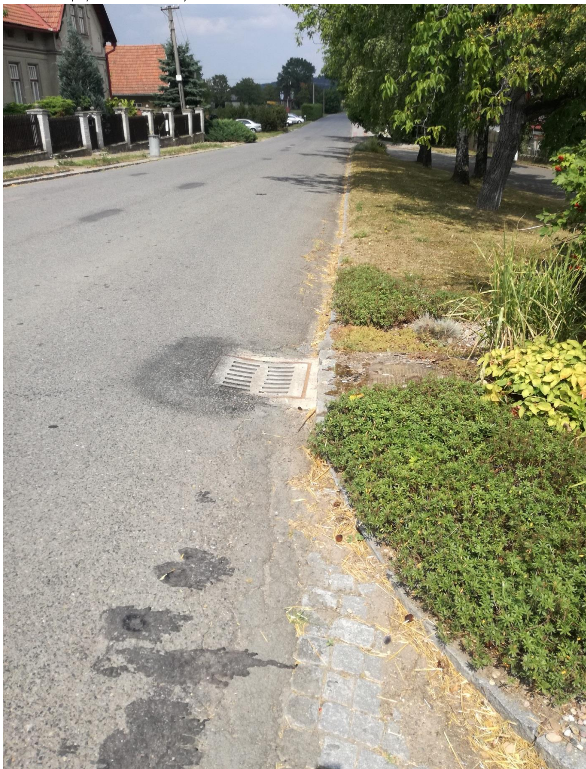
Foto 2: Předmět pasportu místních a účelových komunikací
